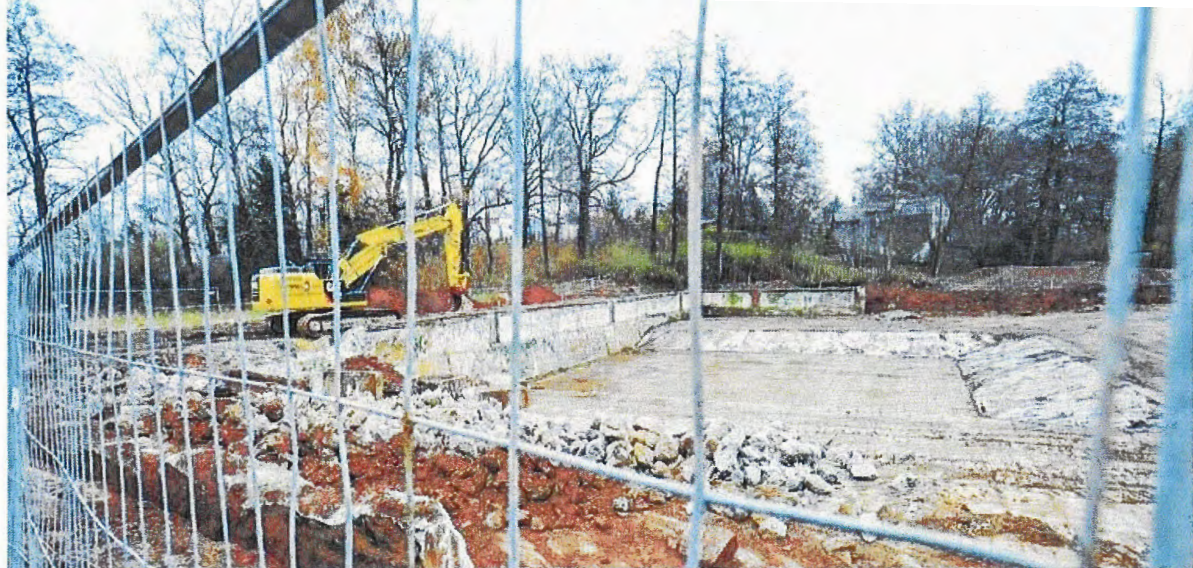
Als Ausgleich für Eingriffe in die Natur beim Neubau der B 174 lässt das Landesamt für Straßenbau und Verkehr zurzeit das Betonbecken des ehemaligen Jagdschänkenbades abbrechen und die Fläche zu einem Naturteich umgestalten. FOTO: ANDREAS SEIDEL
