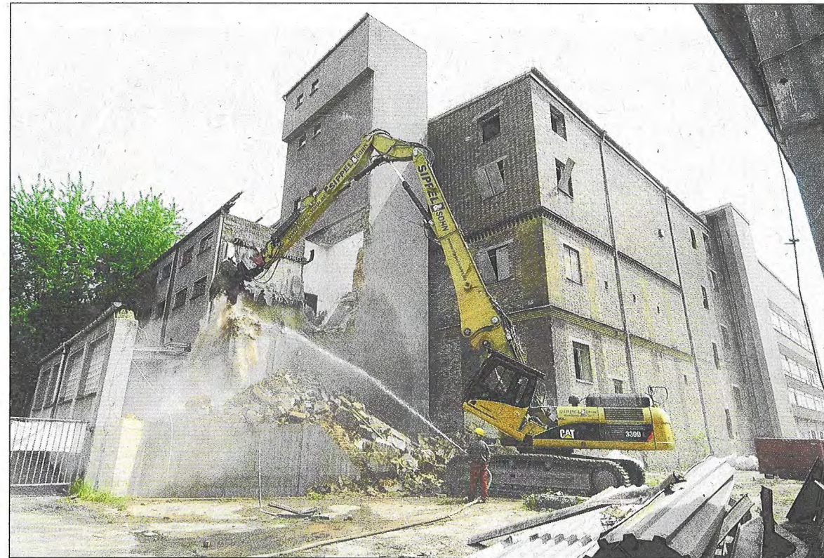
Gestern hat der Bagger erstmals an Gebäudeteilen der ehemaligen Texturseide-Fabrik in Lunzenau genagt. Ab Montag wird das Hauptgebäude abgetragen.
